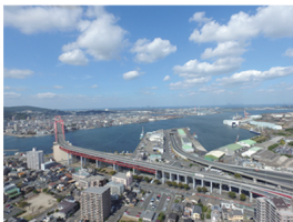
新若戸道路トンネル
