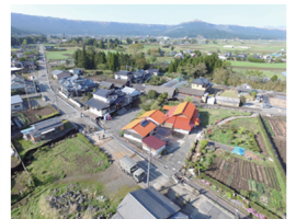
熊本地震災害 阿蘇市内牧甲賀牟田地区 の被災状況
