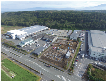
工事進捗状況
