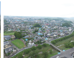
熊本地震災害 益城秋津川付近被災状況
